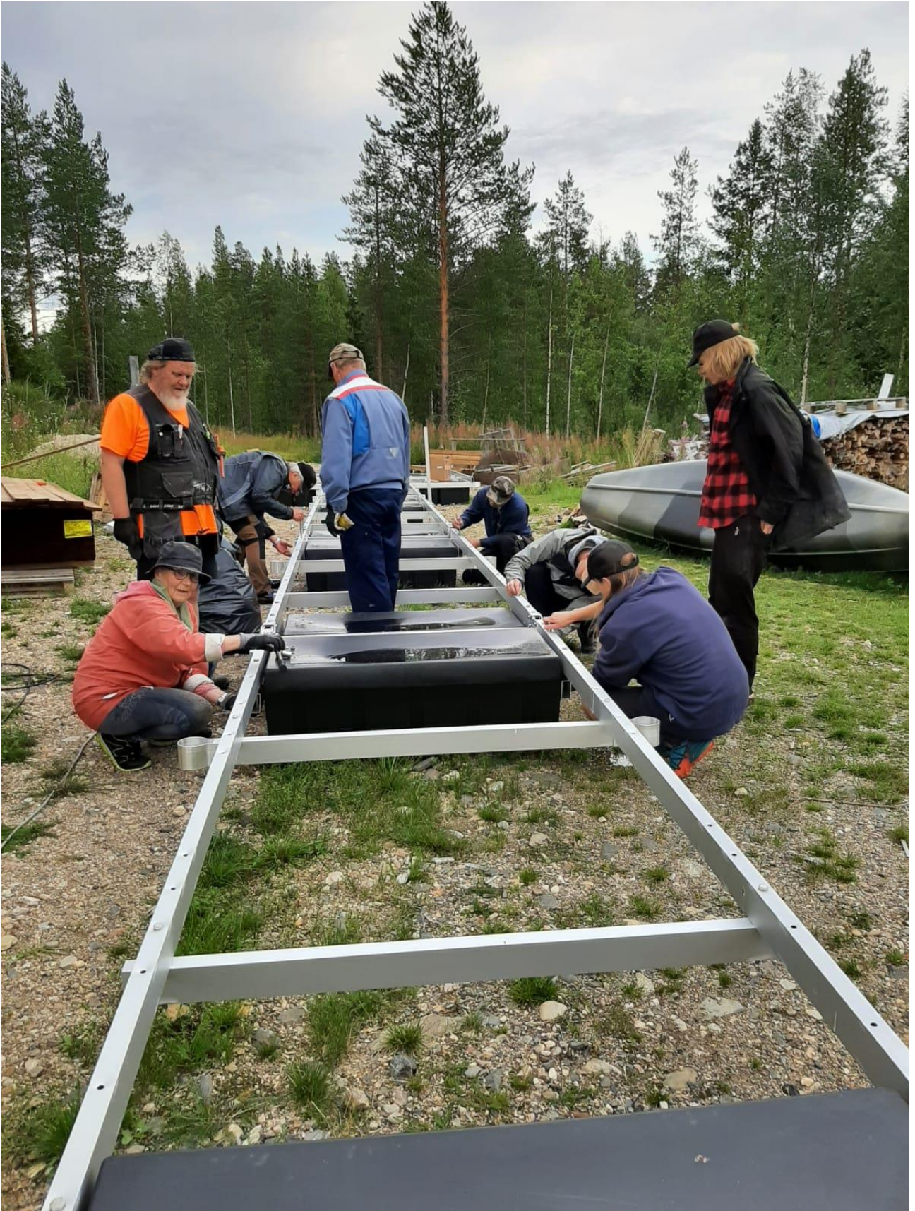
Kootut kävelysiltarungot yhdistettiin toisiinsa (5 x 3,6 m) ja pätyyn kiinnitettiin laiturin neliöosa (3,6x3,6 m)
