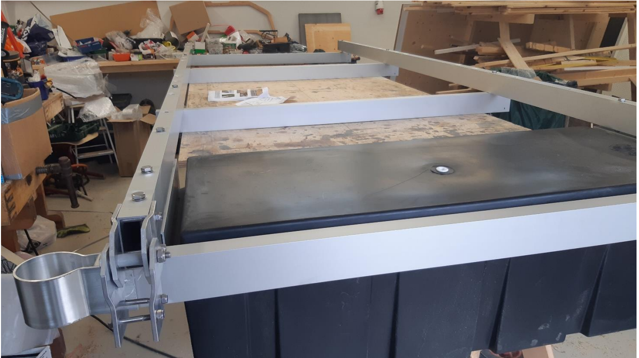
Runkorakenteiden kokoonpanoa verstaalla.
