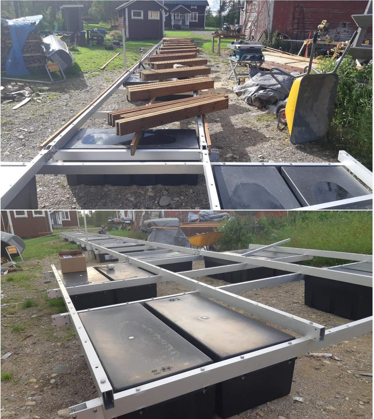
Runko-osat valmiina, odottavat kansirakenteita – piha-alue täyttyy laiturista, pituutta 22,5 m
