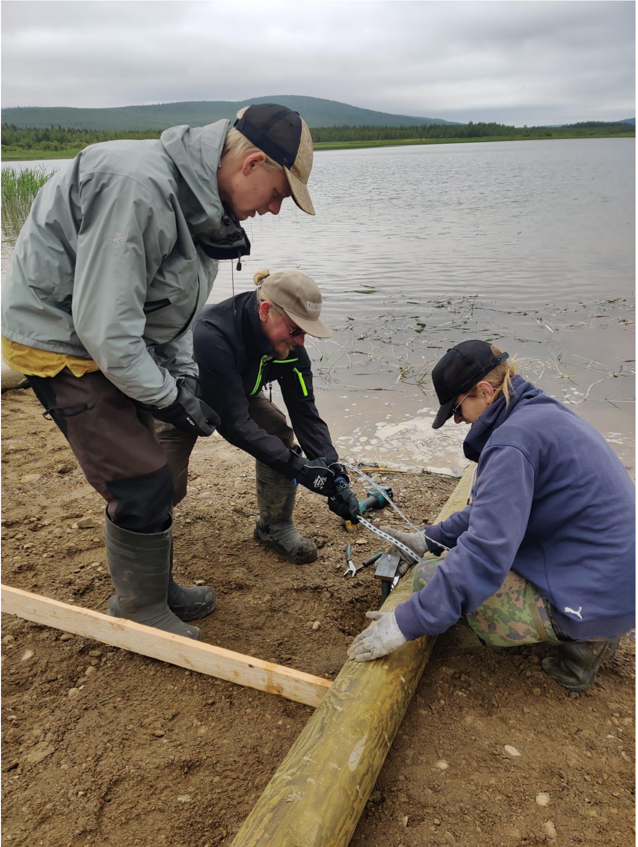
RST-reikänauhalla ja -pulteilla alajuoksut kiinnitettiin maahan painettuihin harustankoihin.
