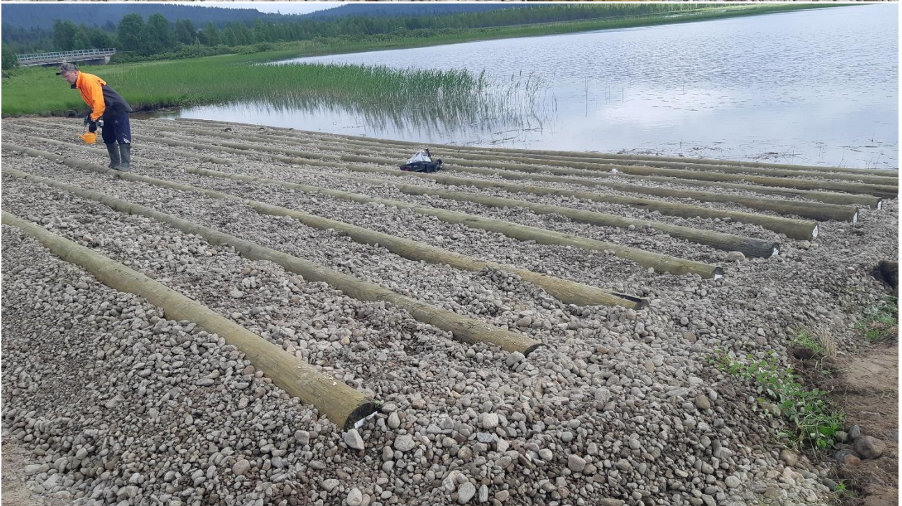
Pitkittäisjuoksut pultattiin RST-kansiruuveilla alajuoksuihin ja välit täytettiin karkealla sepelillä. Kansiruuvienv kannat upotettiin porauksella ja kolo täytettiin ankkurointimassalla, ettei vesi pääse upotukseen.
