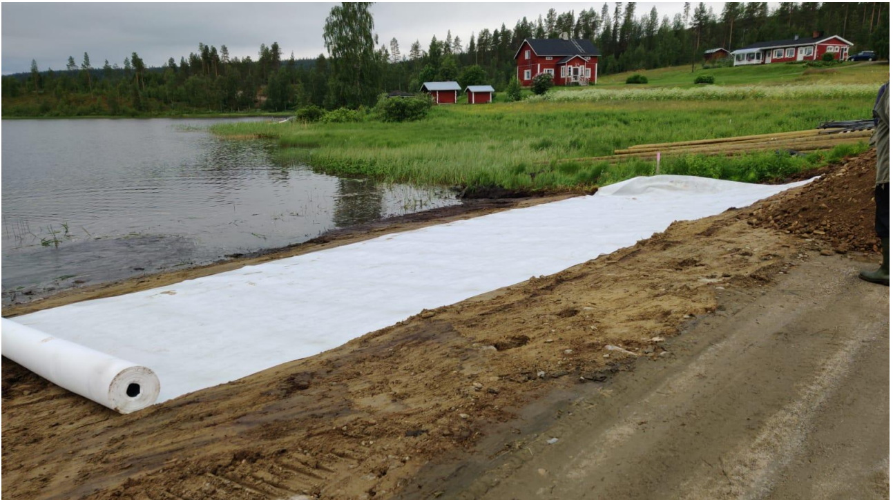
Pintakuorinnan jälkeen levitettiin suodatinkangas ja sen päälle ajettiin 40 cm paksu sorakerros
