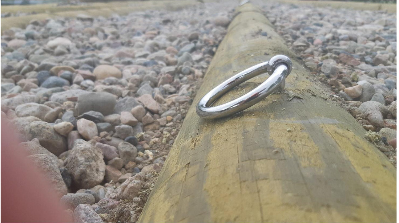
RST-venerenkaat asennettiin pylväsriiviin, veneiden kiinnitystä varten
